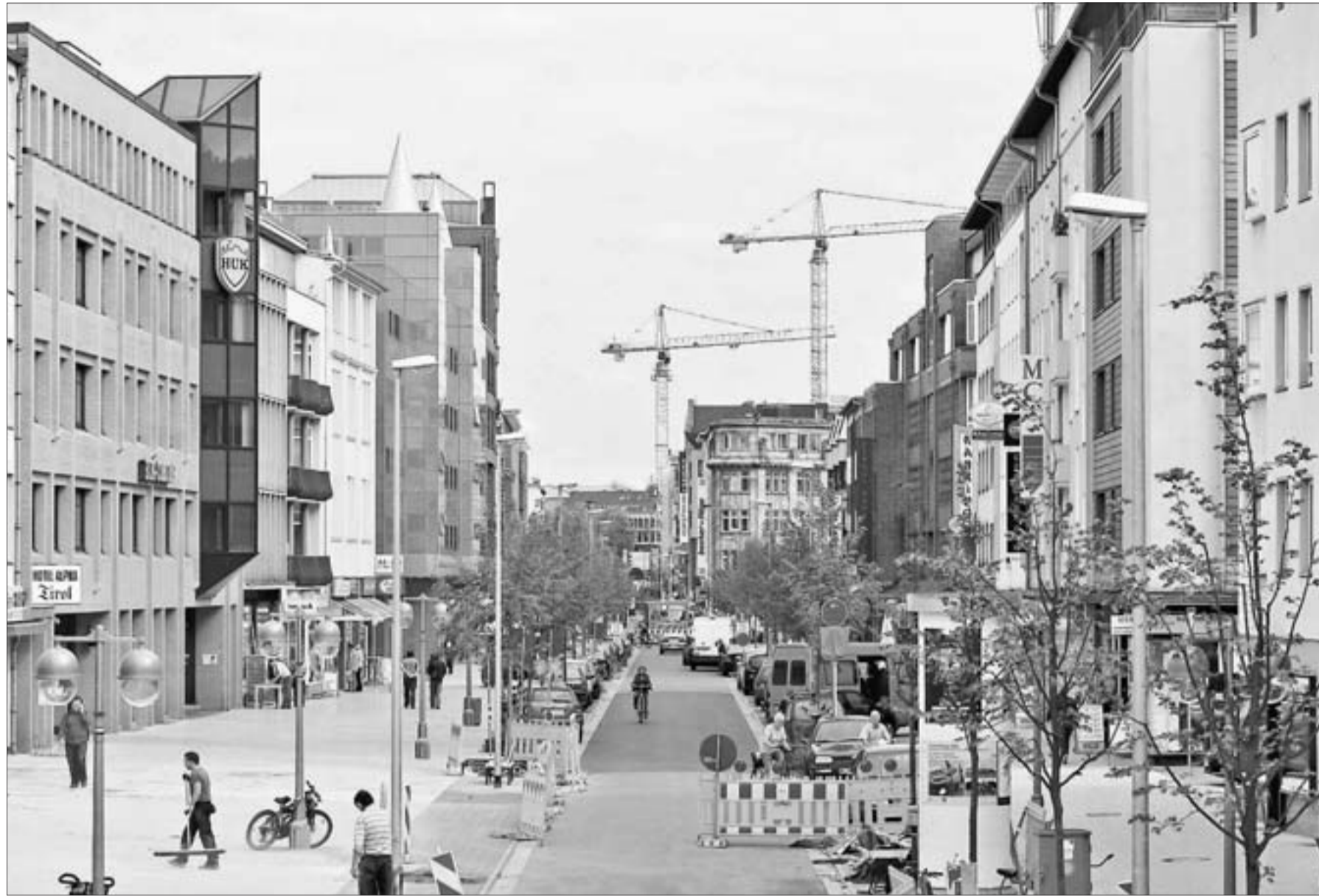
Noch werden letzte Bauarbeiten erledigt, am Freitag dann soll die Lange Laube eröffnet werden.
